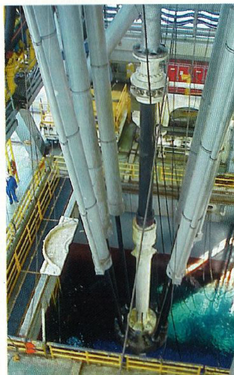
Während des Bohrvorgangs ragen Teile der Hydraulikzylinder, die Kardangelenke und die Plattform in das aggressive Meerwasser. Deshalb ist hier Dichtigkeit und Korrosionsschutz der Superlative gefordert.
